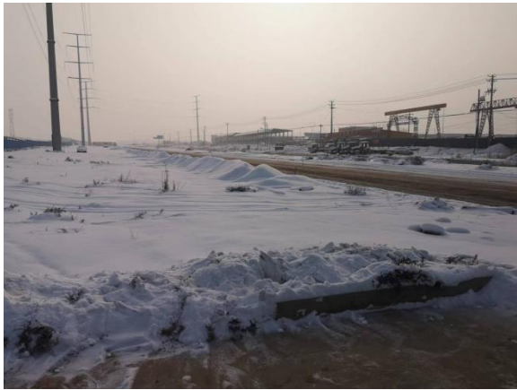
项目区西侧盛达东路
